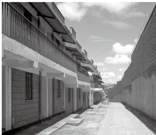
图 6 基贝拉铁路拆迁项目建成后 资料来源：内罗毕大学学生 Warui 拍摄
