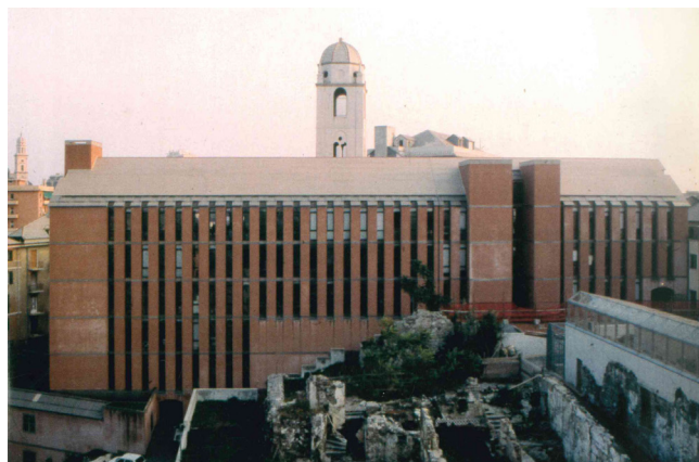
图 4 在老修道院废墟上建立起来的建筑学院主楼
